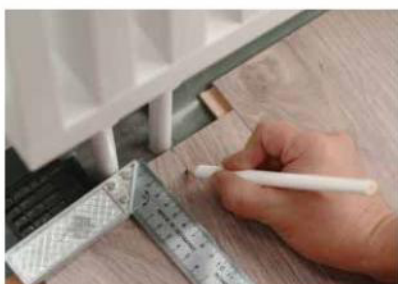
Encadrement de porte et tuyaux de chauffage
